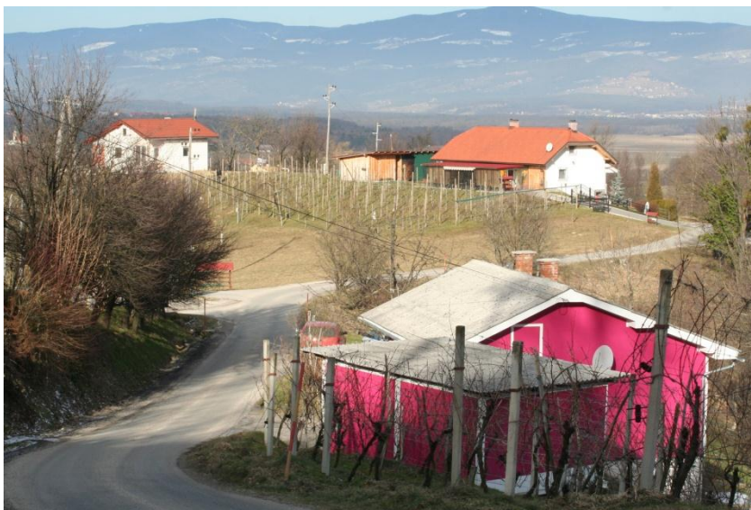
Slika 2: Objekt z napačno barvo fasade lahko poruši celotno podobo naselja.
