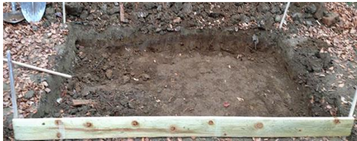
Slika 1: Izkop luknje za visoko gredo. (Vir: Izdelava visoke grede, 2015)
