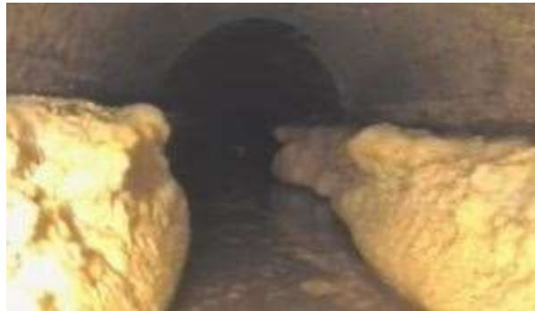
Slika 2: Maščoba v kanalizacijskem omrežju (vir: https://sdzv-drustvo.si/novice/odpadno-jedilno-olje-ni-odpadek-ampak-koristna-surovina/ )
