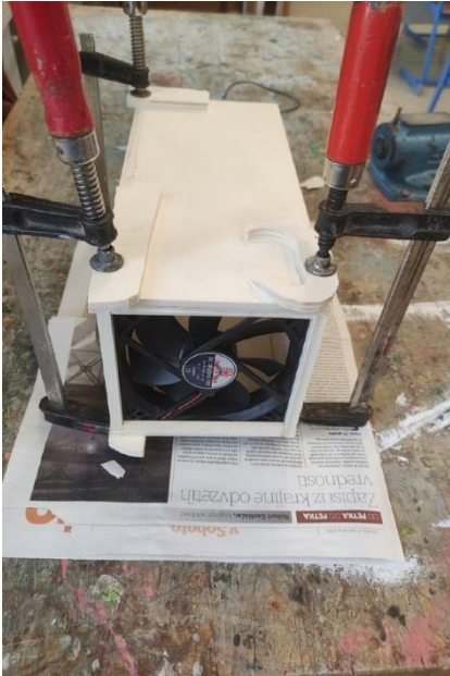
Slika 11: Lepljenje okvirja. (Foto: Renata Kovačič, 2023)
